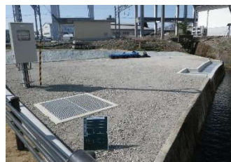
雨水貯留施設を新設
